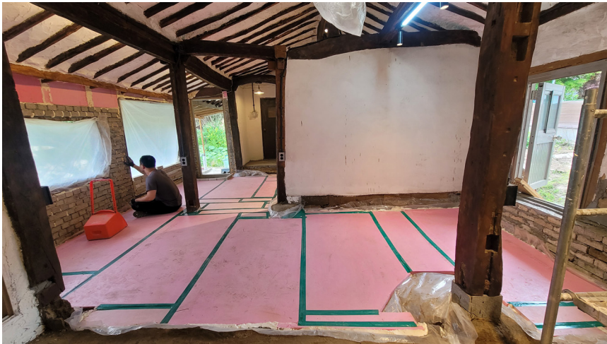
단열재를 바닥에 맞춰 깔고, 테이핑까지 마친 상태
