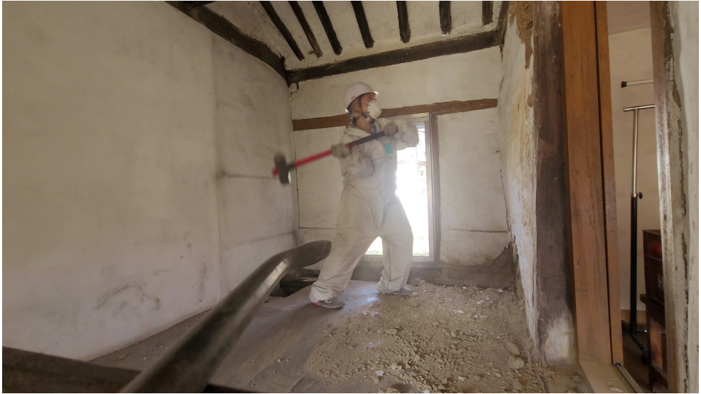
해머로 흙벽을 터는 작업
